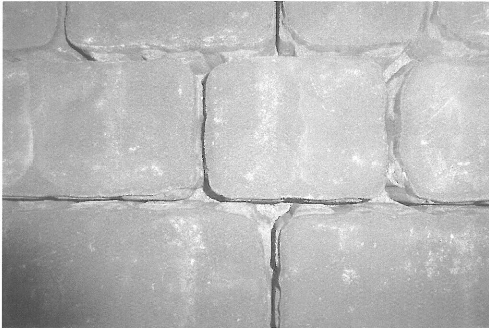
Bild 3: Detail: resultierende Fugenbreite im Eckbereich
